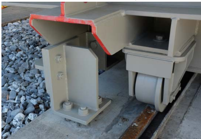
Figura B.3: Trasformatore 110 kV / 60 MVA – Zona sismica Z2 – Ancoraggi (4 rimovibili) con ruote (con l'autorizzazione di axpo).
