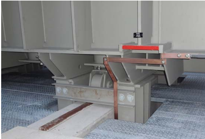
Figura B.4: Trasformatore 110 kV / 125 MVA – Zona sismica Z2 – Ancoraggi (4 rimovibili) con ruote (con l'autorizzazione di axpo).
