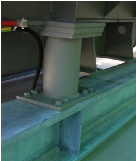
Figura B.4: Trasformatore 110 kV / 125 MVA – Zona sismica Z2 – Ancoraggi (4 rimovibili) con ruote (con l'autorizzazione di axpo).
