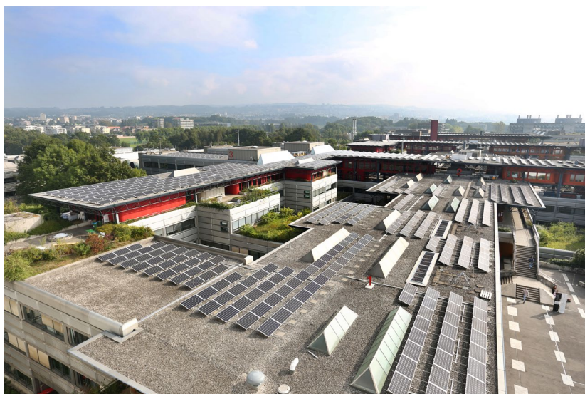
Abbildung 6 Meldepflichtig sind Photovoltaikanlagen, Notstrom- und Netzersatzanlagen, Wasserkraftwerke, Wärme-Kraft-Koppelungsanlagen und weitere Energieerzeugungsanlagen.
