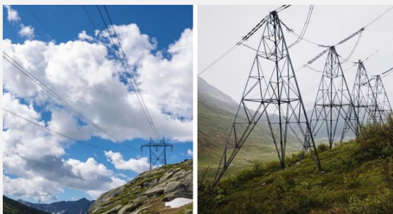
Abbildung 2 Freileitung im Gotthardgebiet
