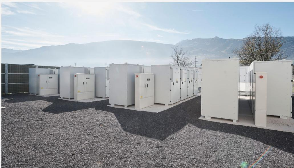
**Figura 3** Potente accumulatore a batteria presso la sottostazione di trasformazione di Sargans (SG)
