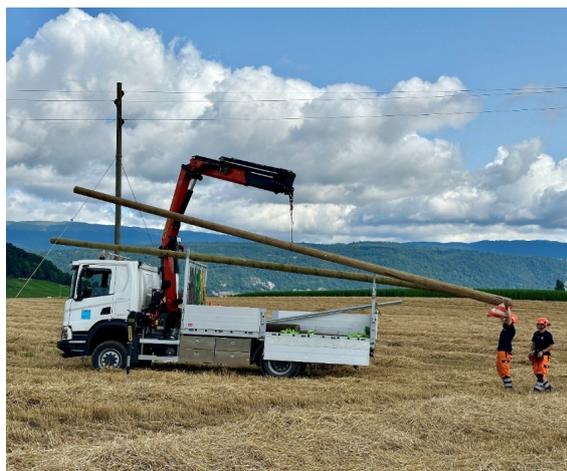
Figura 1 Sostituzione dei pali da parte di BKW presso Erlach (BE)
